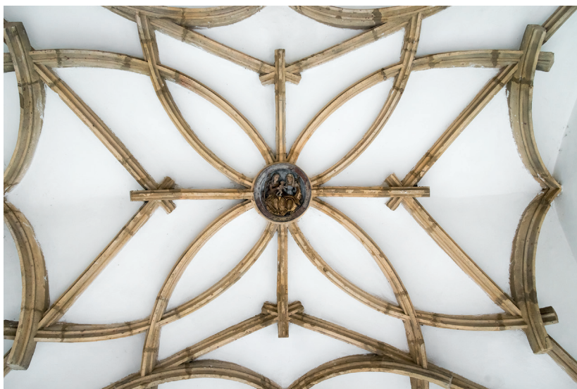
Abb. 5: Brück (Most), Dekanatskirche, Gewölbe der nördlichen Vorhalle, Aufnahme 2019
