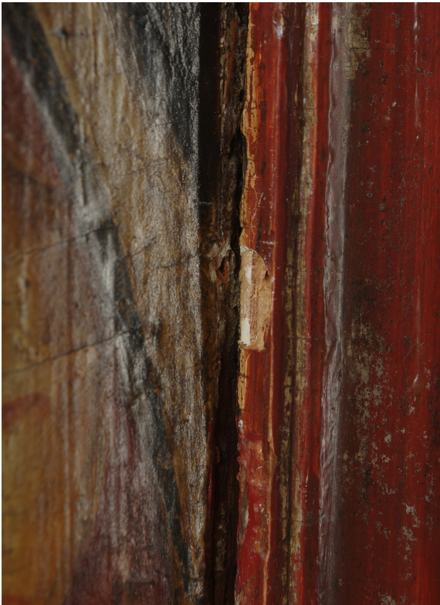
Obr.. č.18 Mistr IW - Votivní deska s Assumptou, zv. Mostecká Stav před restaurováním, detaily poškození polychromie rámu
