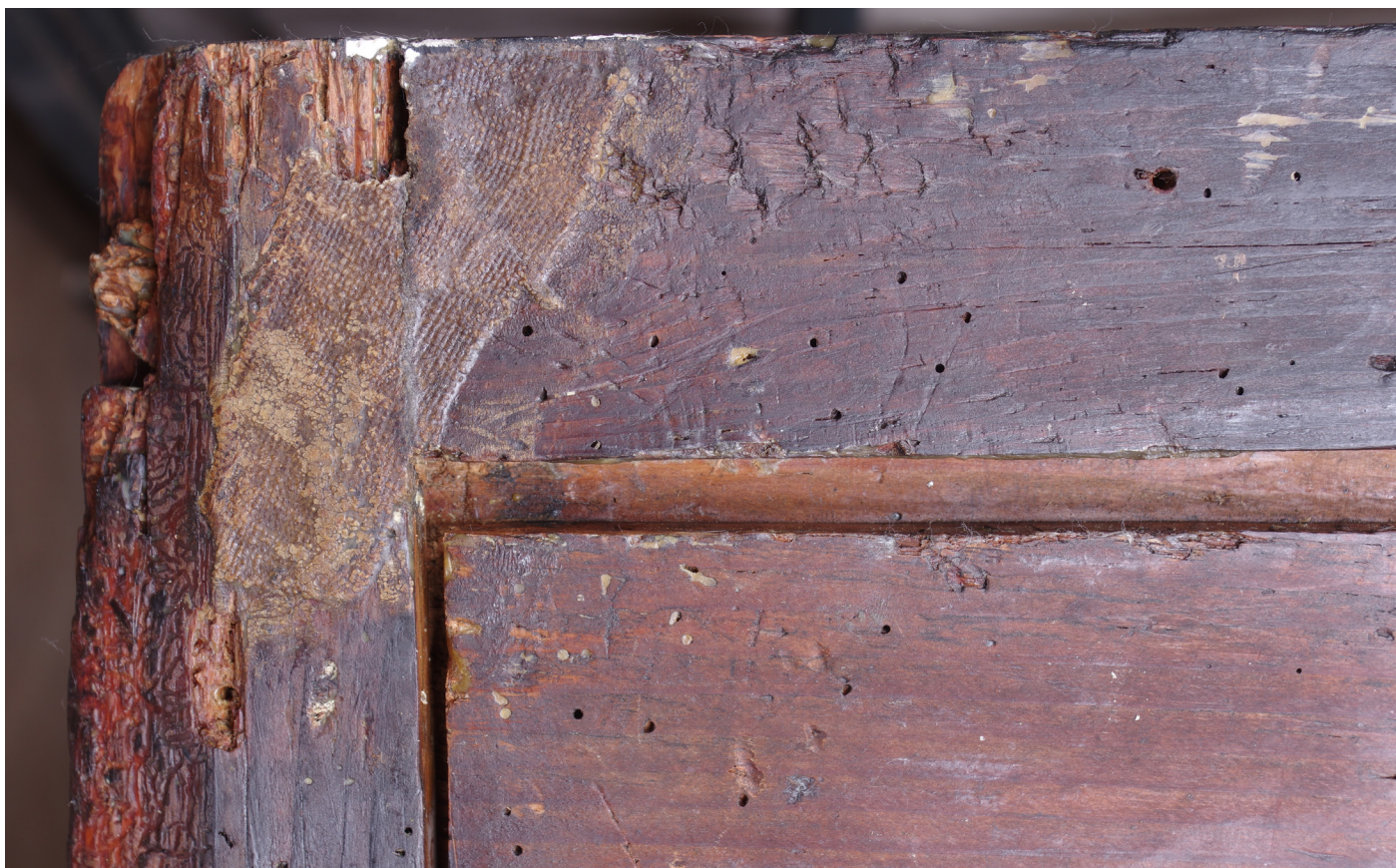
Rub desky průběh ztenčování vrstvy voskopryskyřičné směsi..
