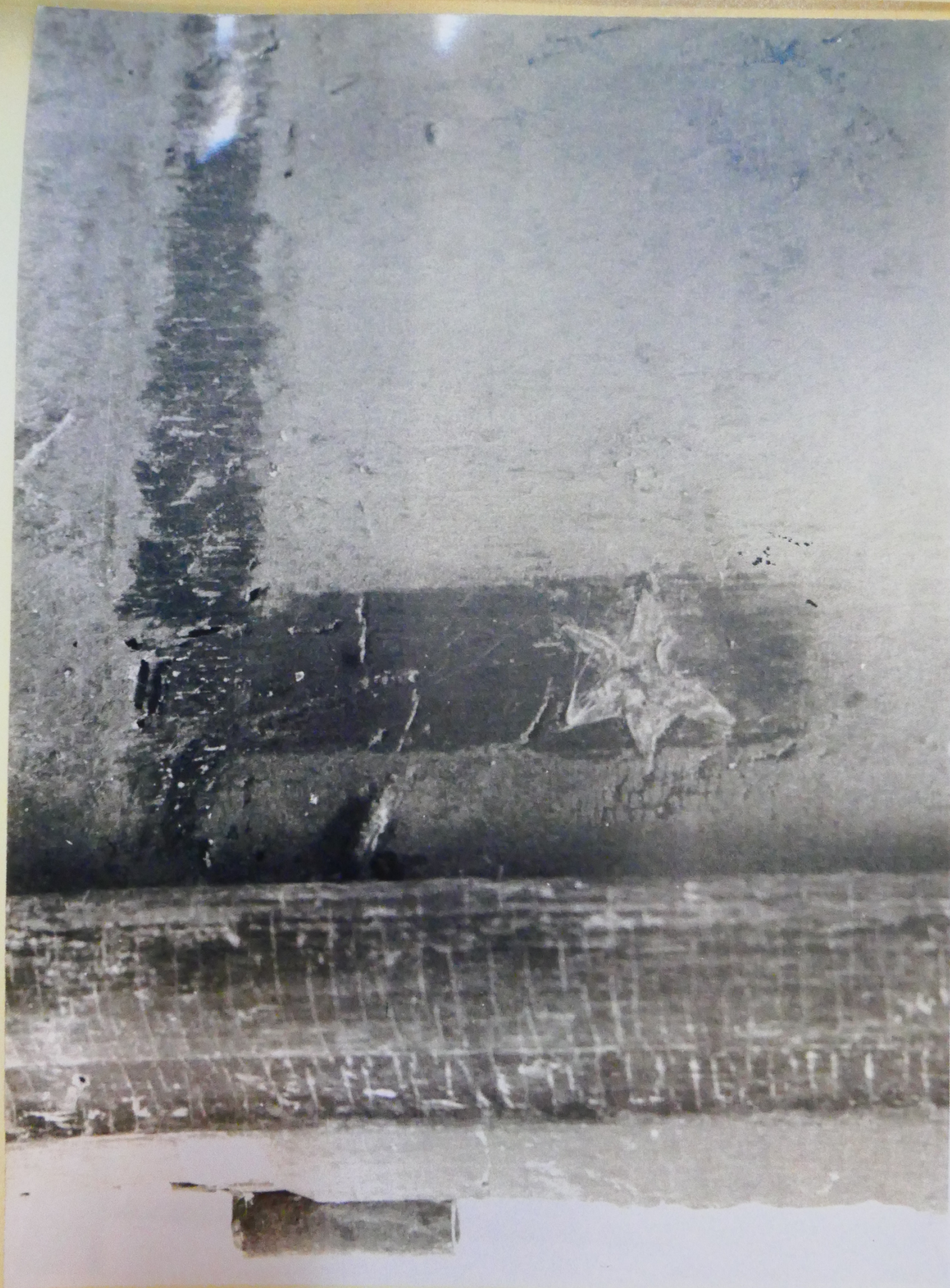
Sonda v přemalbě na boku niky - makrofotografie
