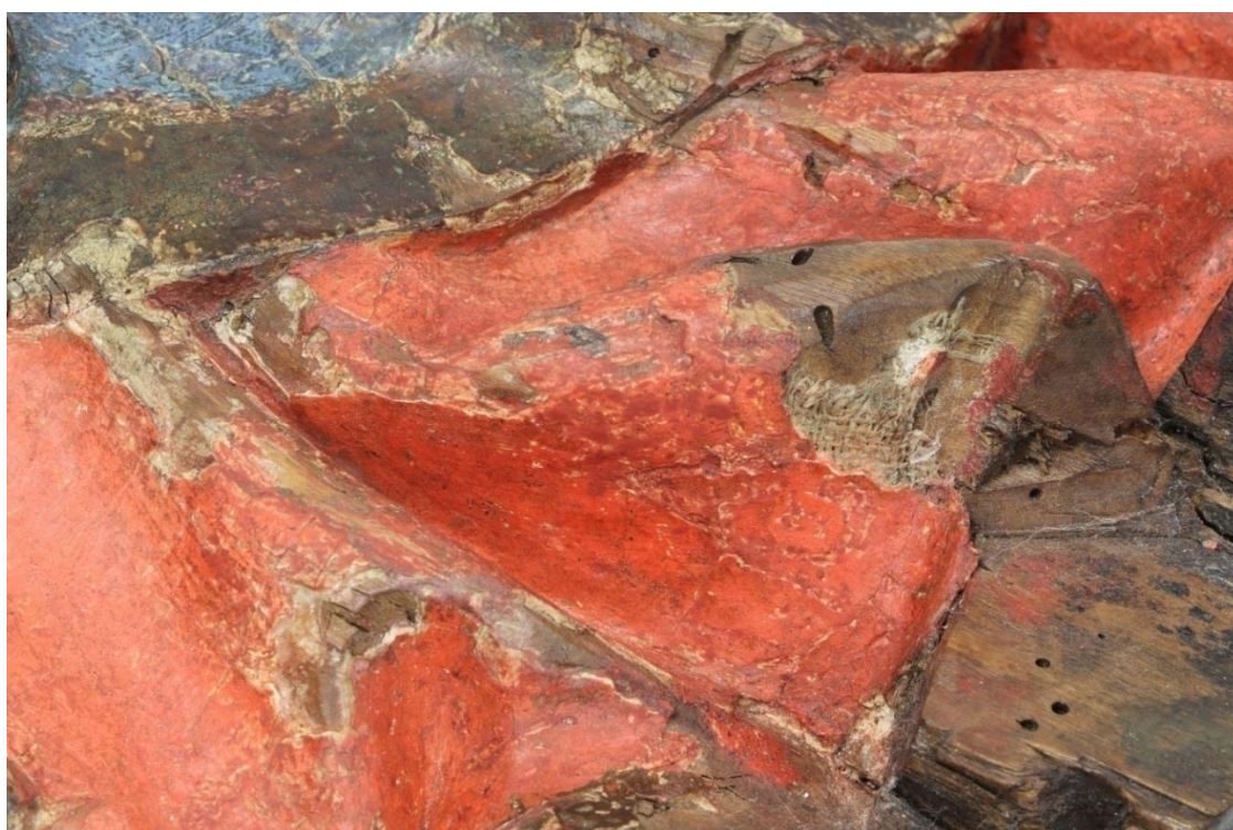
Obr.65 Detail před a po restaurování
